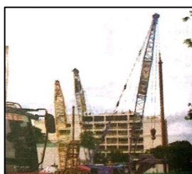
รูป 2.4 การตอกเสาเข็ม
